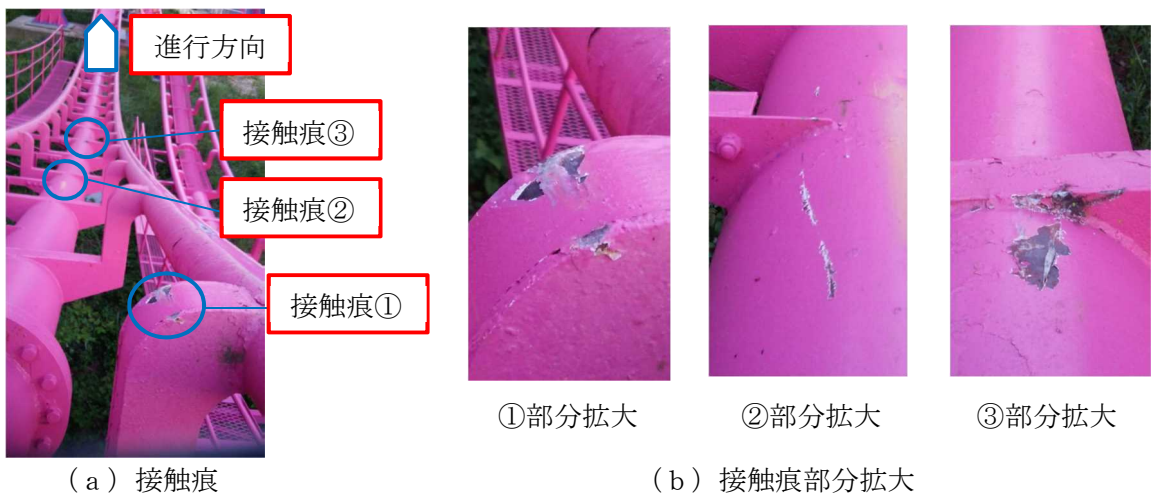
写真1 走路の接触痕
