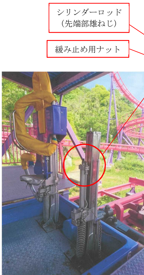
(a) 支柱部分
