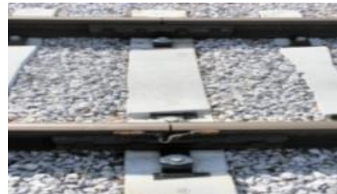
【コンクリート枕木(軌道改良)】
