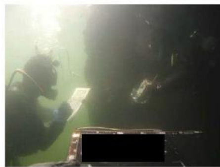
潜水目視状況写真
