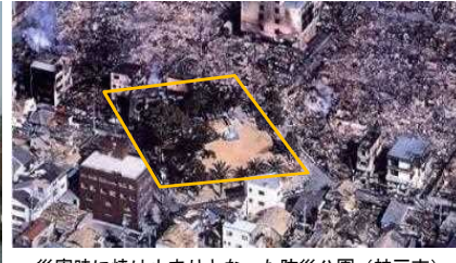
災害時に焼け止まりとなった防災公園(神戸市)
