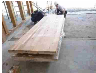
CLTの現場搬入
