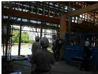
CLTの建て込み
