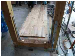
CLTの建て込み
