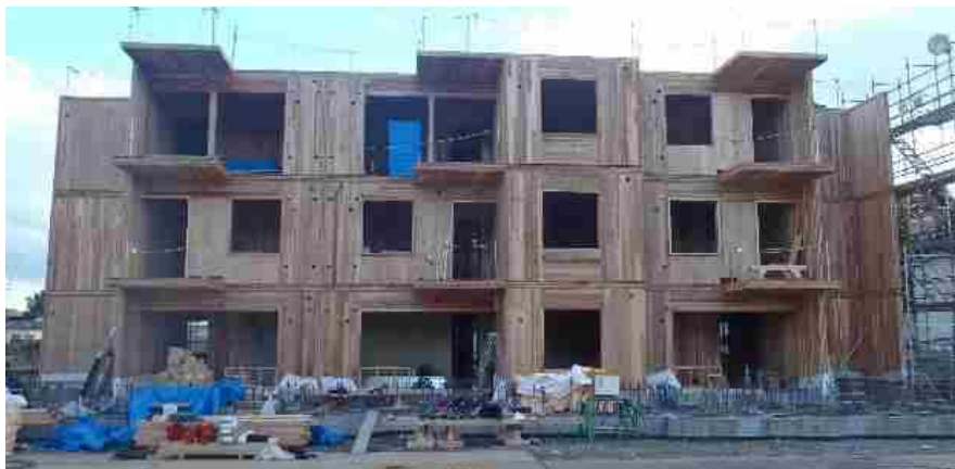
無足場による 3 階までの建て方
