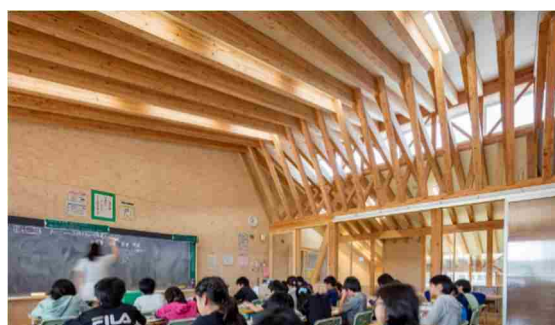
普通教室（招き屋根小屋組）状況
