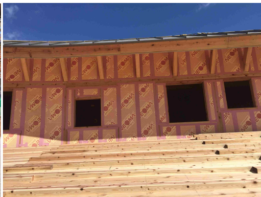
写真 10：断熱材を全面張りする事で高い省エネ効果が得られている。
