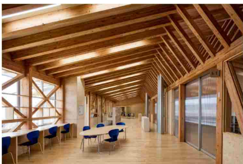
普通教室（招き屋根小屋組）状況
