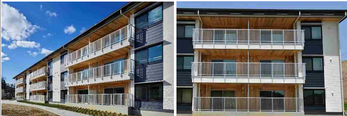
CLTパネルを現しとしたバルコニー
