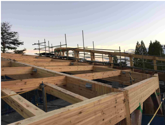
写真 7：接合金物は外部への露出は無い。
