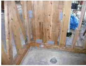
設備専用壁を設ける
