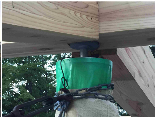
写真 8：外部廊下の鉄骨柱とはエポキシ樹脂により高強度で固定。
