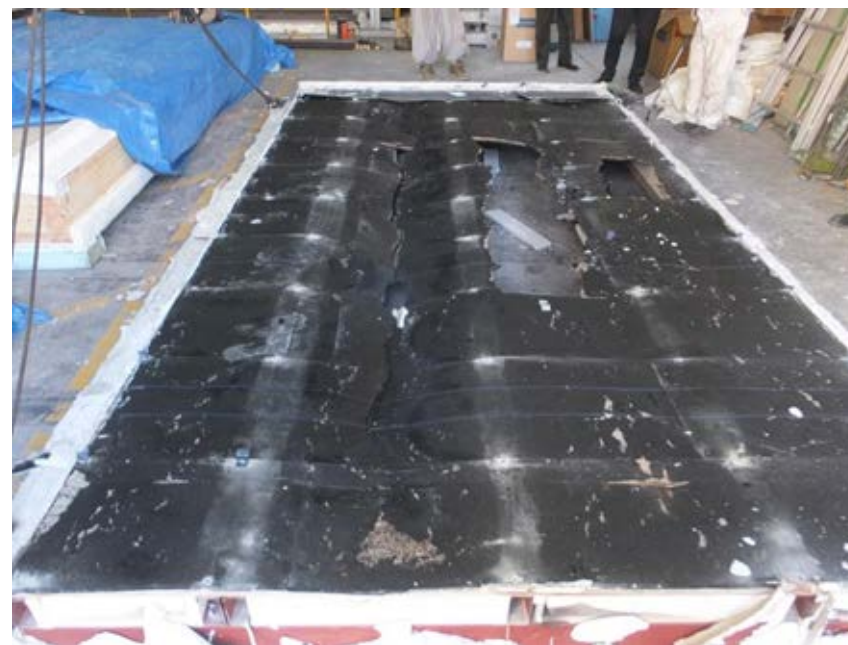
試験後のアスファルトルーフィングの状況
