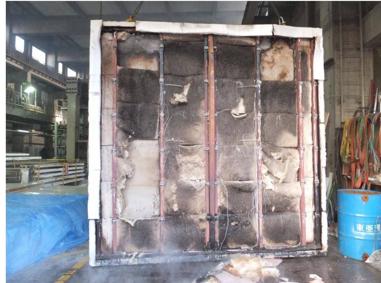
鉄骨下地 加熱側表面(加熱後)
