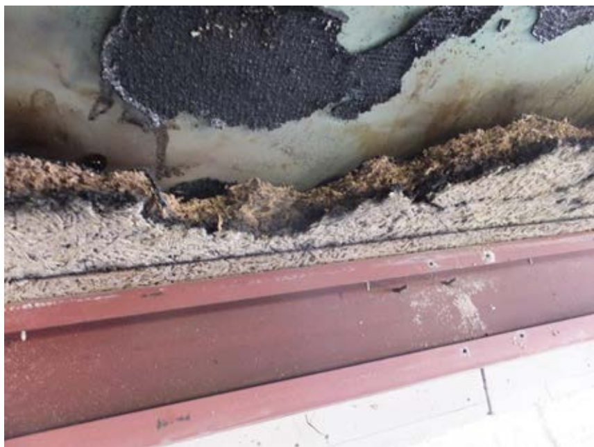
試験後の垂木及び野地板の炭化状況
