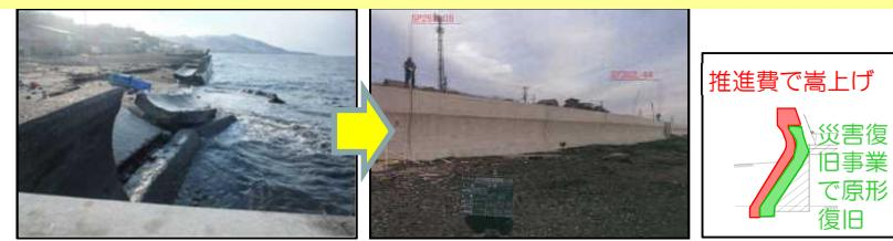
被災した護岸を災害復旧事業による原形復旧にあわせて、推進費により嵩上げを実施。
