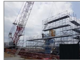
【足場設置状況】
