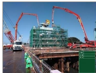
【中埋コンクリート打設状況】
