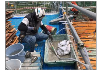
【グラウト注入状況】
