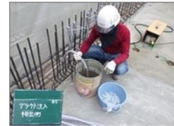
[グラウト注入状況]
