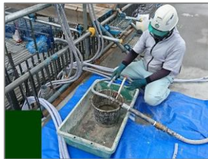
[グラウト注入状況]
