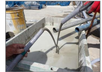
【グラウト注入状況】
