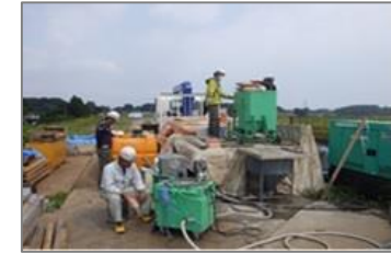
[グラウト注入状況]
