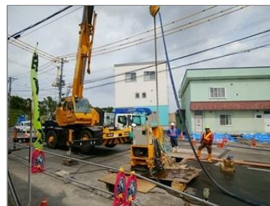
【施工状況（二重管工法）】
