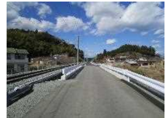
高線量区間の避難用道路の整備
