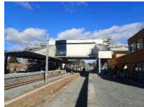
橋上化工事中の双葉駅
