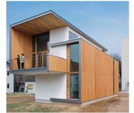
CLT工法による実験棟
