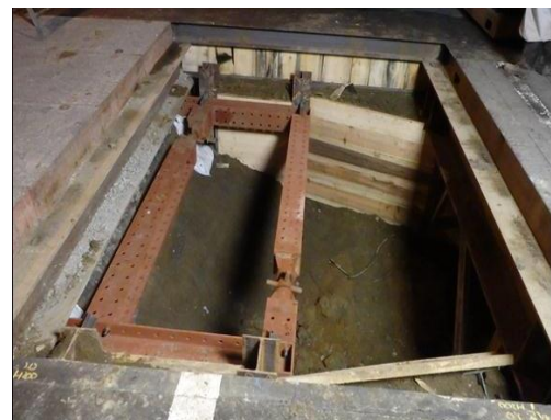
山留支保工設置完了
