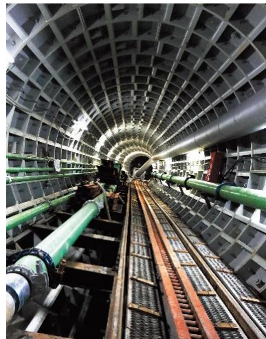
仲通り縦断洞道（施工中）
