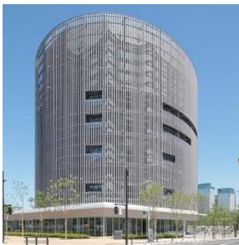
スマートエネルギーセンター全景
