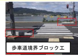
対策例：園児の移動経路（交差点）において発生した死傷事故を受けて、緊急点検の結果、危険箇所に防護柵等を設置。
