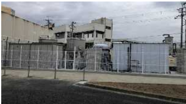
図11 地下水浄水施設（西側からの全景）
