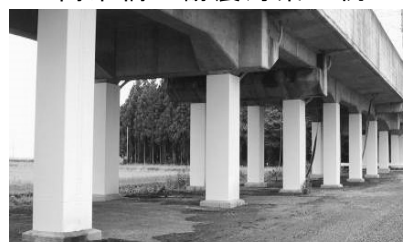
鋼板巻きによる 高架橋の耐震補強
