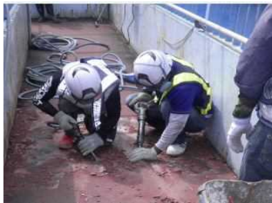
薄層舗装はぎ取り
