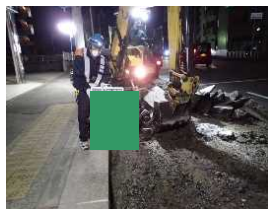
直接掘削積込
