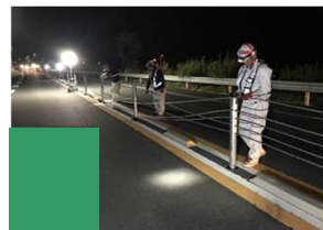
ワイヤロープ設置作業
