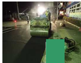
路床及び路盤の転圧 (振動ローラ)
