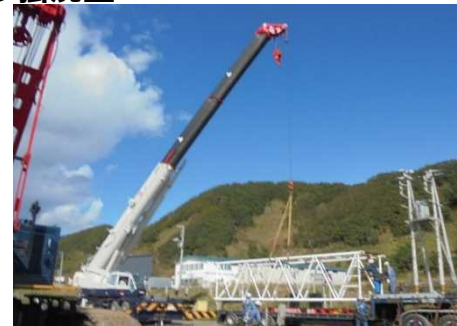
分解・組立 (ラフテレーンクレーン使用)
