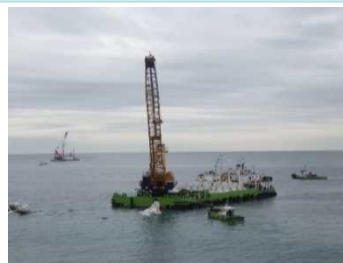
ブロック据付
