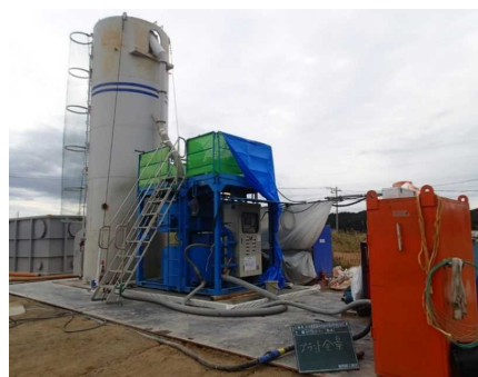
スラリープラント設置状況
