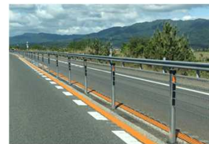
ワイヤロープ設置状況
