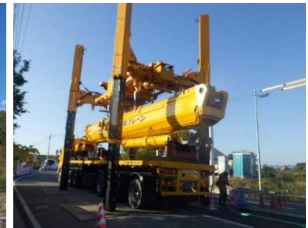
分解・組立(リフター使用)
