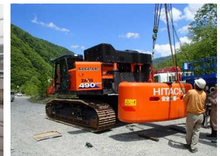
分解・組立状況
