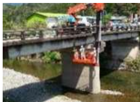
インフラの維持管理(点検作業)
