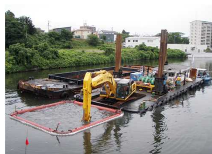
バックホウ浚渫船による浚渫作業
