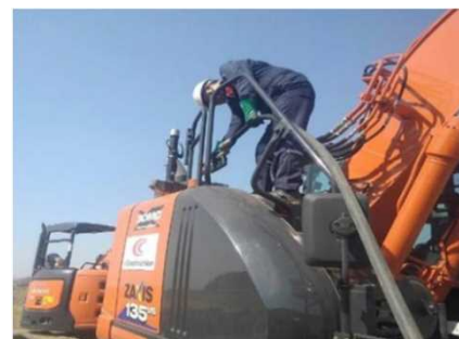
バックホウ給油状況
