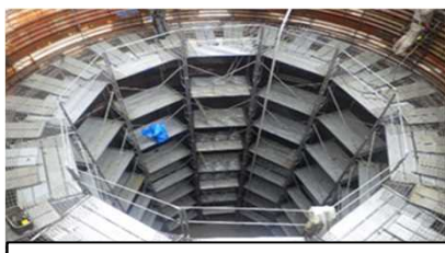
坑内足場設置状況
