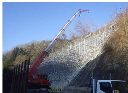
単管傾斜足場
