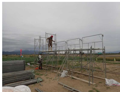
手摺先行型枠組足場
