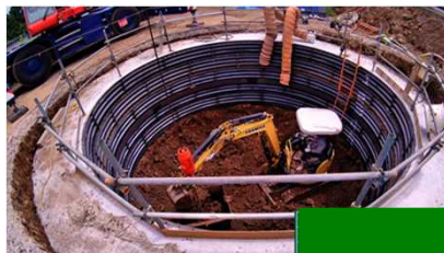
小型バックホウによる掘削作業状況 (B-2工法)
