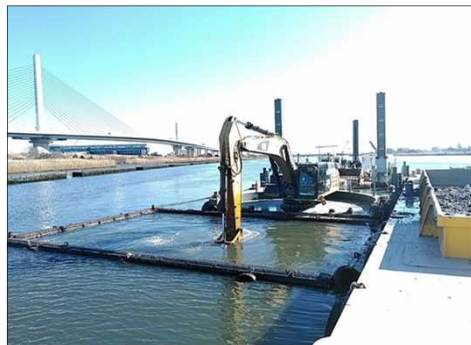
バックホウ浚渫船による浚渫作業
