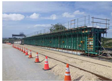
主桁製作用型枠（鋼製型枠）
