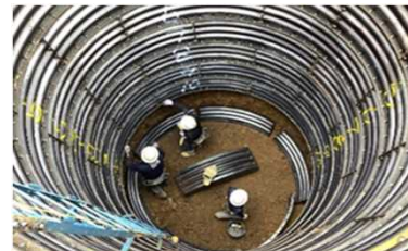
ライナープレートの組立作業状況
