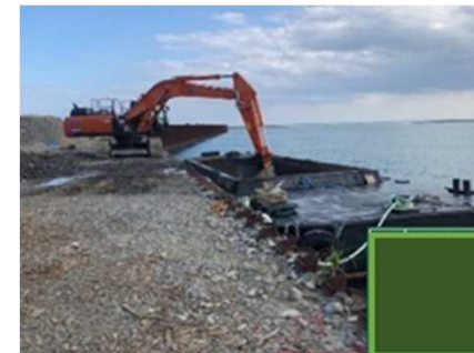
浚渫土の揚土作業
