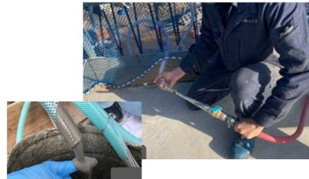
グラウト注入作業状況
