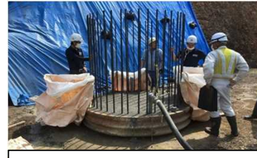
グラウト注入状況
