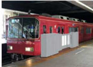
実証試験ホーム柵設置イメージ
