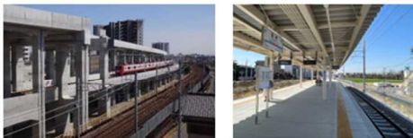
名古屋本線上下線(豊橋方面) 高架後の知立駅付近 若林駅仮線ホーム
