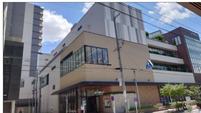
北東側からの外観 (左手奥の高い建物が賃貸住宅)
