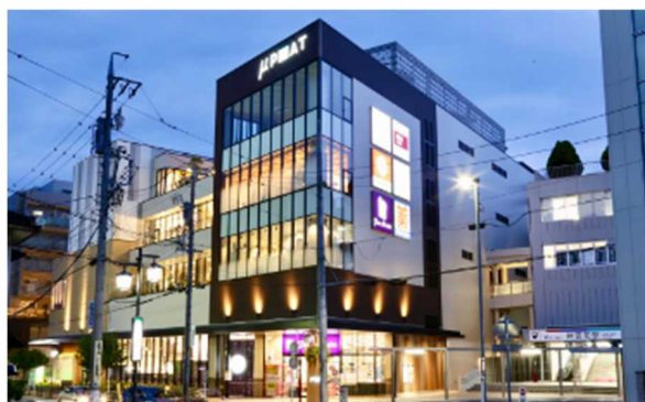
北西側からの外観 (接続デッキにて右手の神宮前駅と直結)
