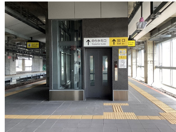
円滑な乗換流動確保のため、EVの大型化(敦賀駅)
