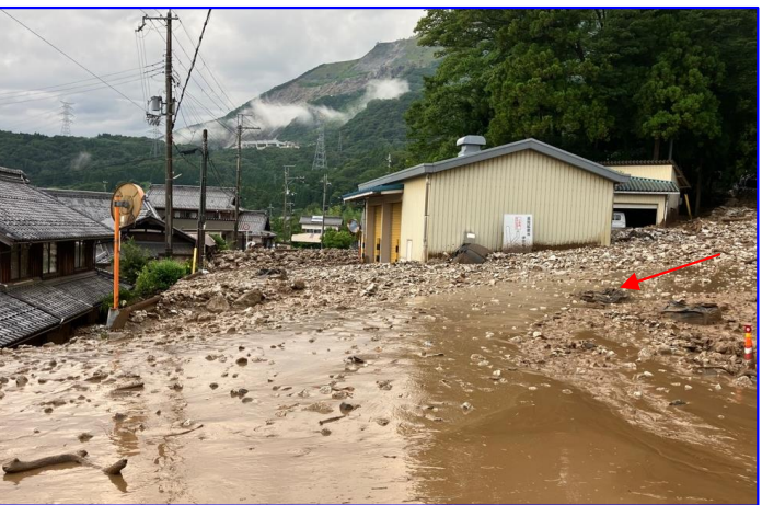
7/25 土石流等 まいばらし いぶき 滋賀県米原市伊吹
