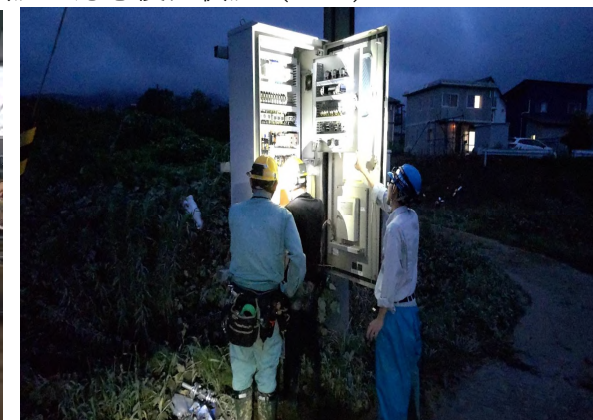
揚水機能の復旧確認
