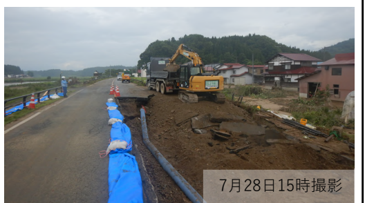
鮭川(右岸6.3kp) 7月25日 被災確認 堤防亀裂(裏法崩れ) L-70m
