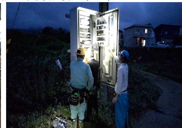
揚水機能の復旧確認
