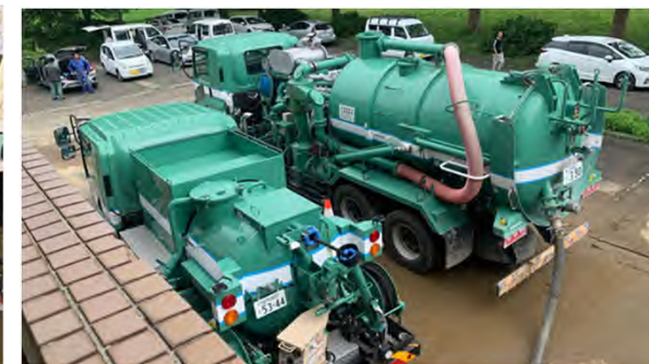
バキューム車による応急対応
