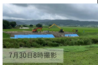
石沢川(支川) 法面整形、大型連結ブロック設置
