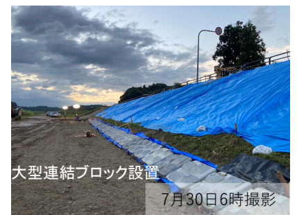
鮭川(右岸6.3kp) 7月25日 被災確認 堤防亀裂(裏法崩れ) L=70m
