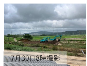
子吉川(本川) ※荒締切盛土(岩ズリ) 施工中
