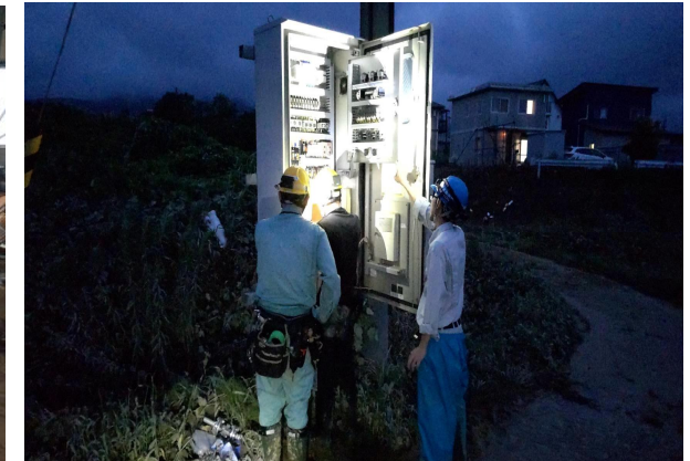
揚水機能の復旧確認
