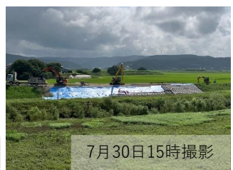
石沢川(支川) 法面整形、大型連結ブロック設置
