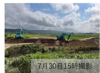
子吉川(本川) 荒締切盛土(岩ズリ) 施工中
