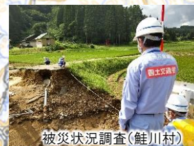
被災状況調査(鮭川村)
