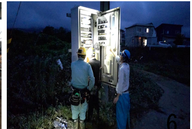
揚水機能の復旧確認
