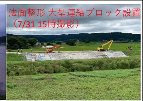
■鮭川堤防亀裂(裏法崩れ)箇所緊急復旧断面
