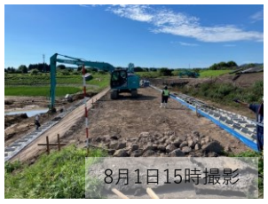
子吉川(本川) 大型連結ブロック設置
