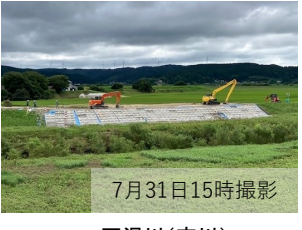
石沢川(支川) 大型連結ブロック設置
