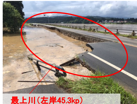
最上川(左岸45.3kp) 7月26日 被災確認 堤防欠損 L=100m
