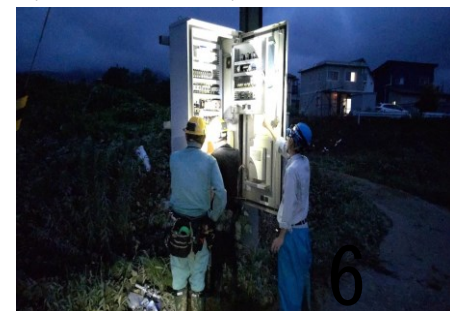
揚水機能の復旧確認
