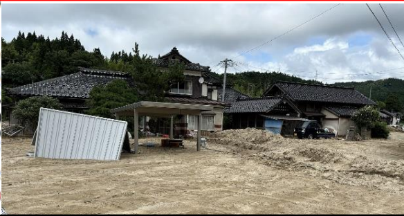
堆積土砂排除事業活用予定箇所(山形県酒田市)
