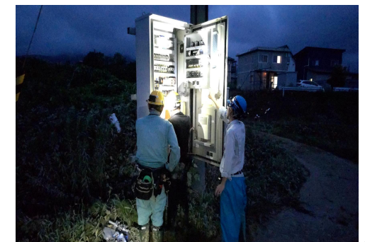
揚水機能の復旧確認
