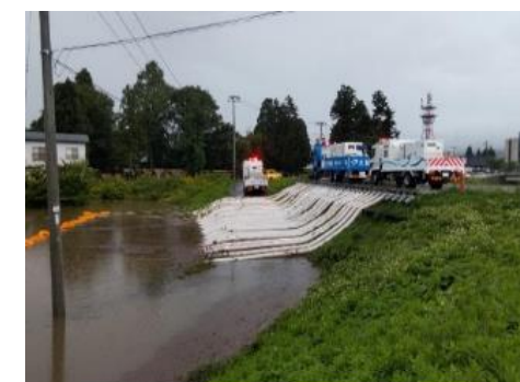
排水ポンプ車による排水活動 (秋田県大仙市)
