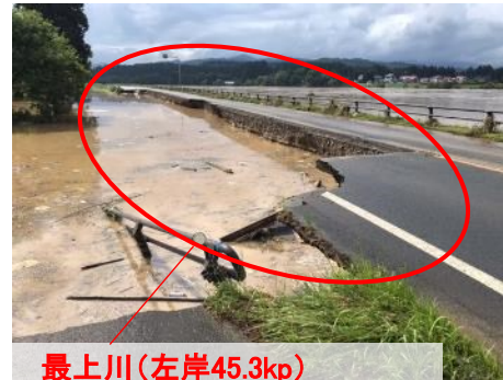
最上川(左岸45.3kp) 7月26日 被災確認 堤防欠損 L=100m
