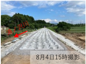
子吉川(本川) 大型連結ブロック設置完了
