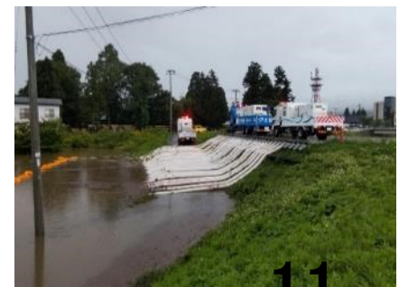
排水ポンプ車による排水活動 (秋田県大仙市)
