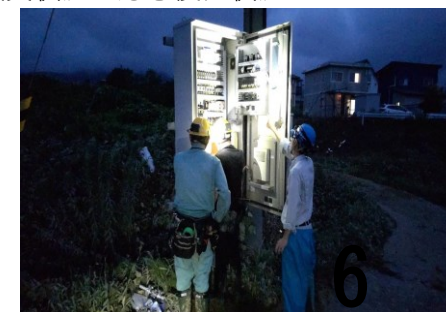
揚水機能の復旧確認
