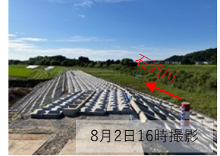
石沢川(支川) 大型連結ブロック設置完了
