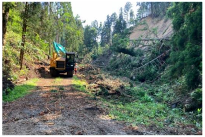
林道(工事用道路)啓開状況
