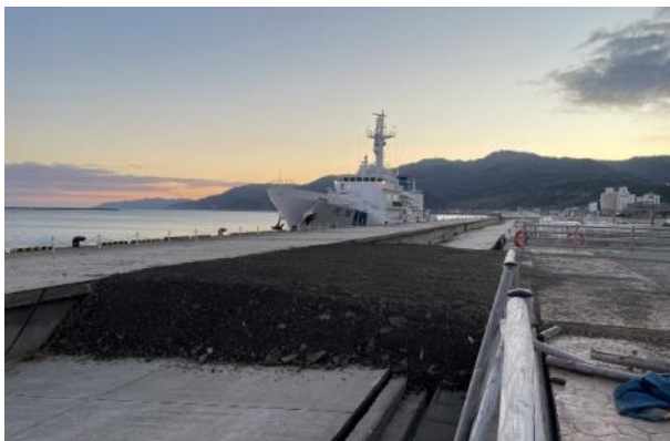
応急復旧後の状況
