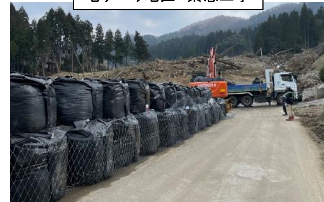
地すべり地区 緊急工事
