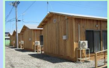
木造仮設住宅(設置例)
