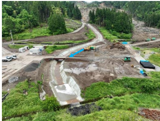
仮排水路 整備完了
