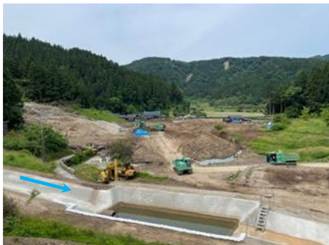
崩壊地末端部 排土状況
