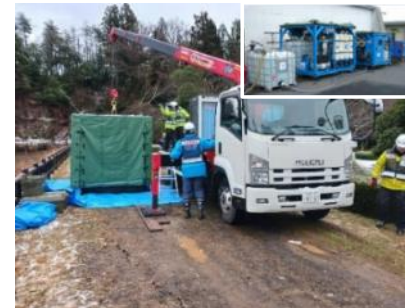
可搬式浄水施設の設置 (石川県珠洲市)
