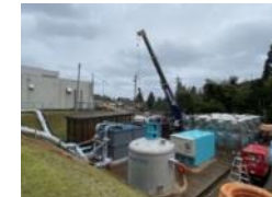
可搬式浄水装置の設置 （珠洲市）
