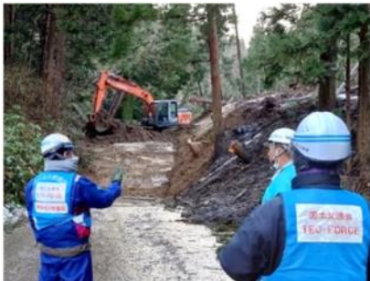
建設業者と連携した道路の緊急復旧 (石川県輪島市)
