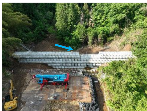
応急対策工事状況（寺地川） ブロック堰堤設置完了
