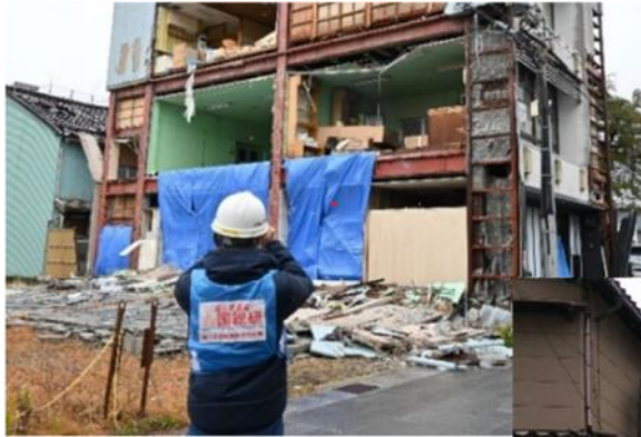
建築物の損壊状況（七尾市）
