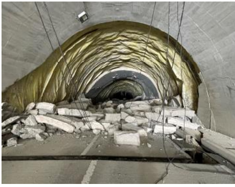
国道249号大谷トンネル（珠洲市）
