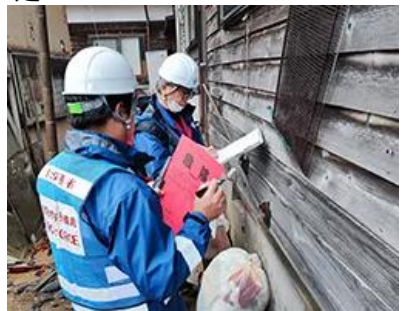
被災建築物応急危険度判定 (石川県穴水町)
