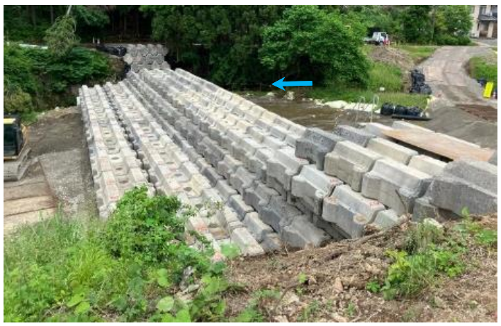
ブロック堰堤 設置完了
