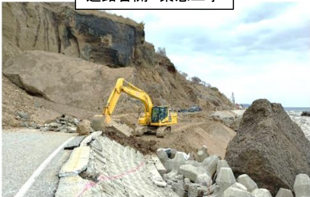
道路啓開 緊急工事
