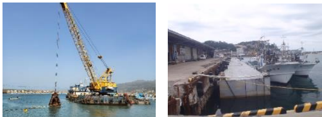
小型船だまりの浚渫作業の状況(4/19) 移動が完了した漁船(4/23)
