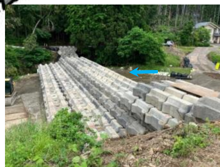
応急対策工事状況（鈴屋川（牛尾川）） ブロック堰堤設置完了
