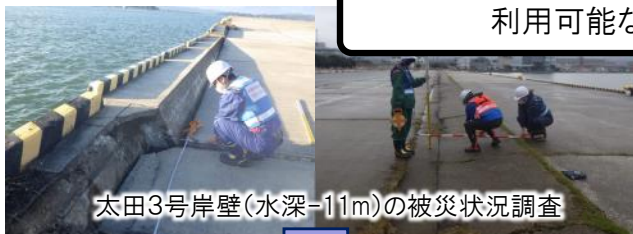
岸壁背後に段差・亀裂
