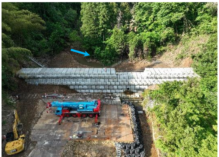
ブロック堰堤 設置完了
