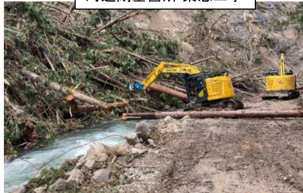
河道閉塞箇所 緊急工事
