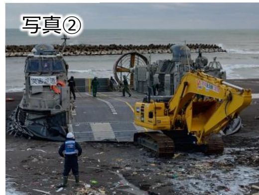
深見海岸 海側からの重機運搬（1月14日撮影）
