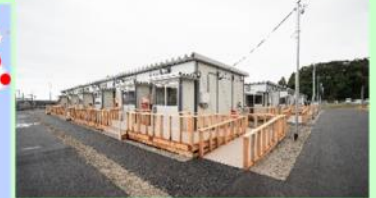
プレハブ住宅(輪島市完成事例)
