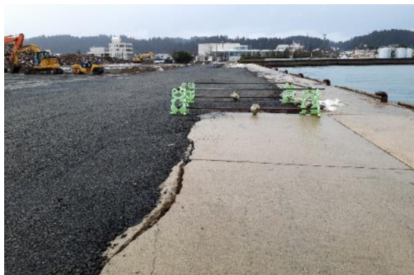
応急復旧後の状況
