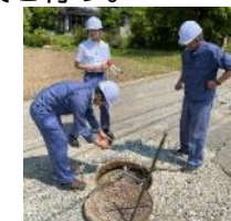
再度災害防止に向けた 被災メカニズム調査（輪島市）
