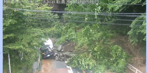
いせはら 国道246号(神奈川県伊勢原市) 土砂崩落 しんぜんば 新善波トンネル坑口(東京側)
