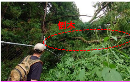
岩山南公園（倒木によるフェンス破損）
