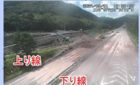
E34 大分道 湯布院IC～日出JCT 【作業状況②: 9/1 12:00時点】
