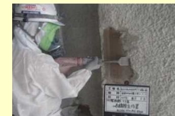
設備室廻り等の鉄骨のアスベスト含有耐火被覆除去
