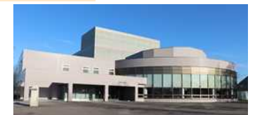
防災体制構築に必要な防災設備の改修総合文化会館防災対策(中標津町)
