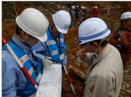
TEC-FORCEによる土砂災害危険箇所の点検【安平町】
