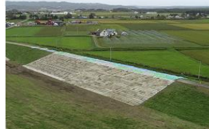
緊急復旧工事完了【9月13日】
