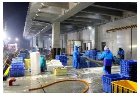
屋根付き岸壁 整備後
