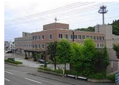
重要インフラの緊急点検(官庁施設)
