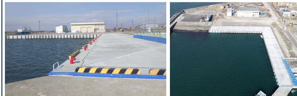
東港区物揚場 (-3m) の復旧完了状況
