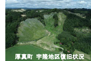
厚真町 宇隆地区復旧状況
