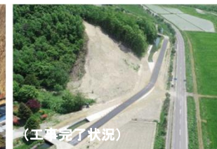
新鷲川地区 川西幹線用水路 (復旧状況)
