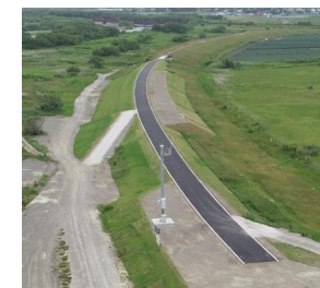
被災堤防の本復旧については、7月30日に完了。
