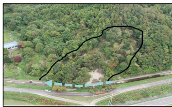
【新鷲川地区】川西幹線用水路 流入した土砂による開水路の閉塞
