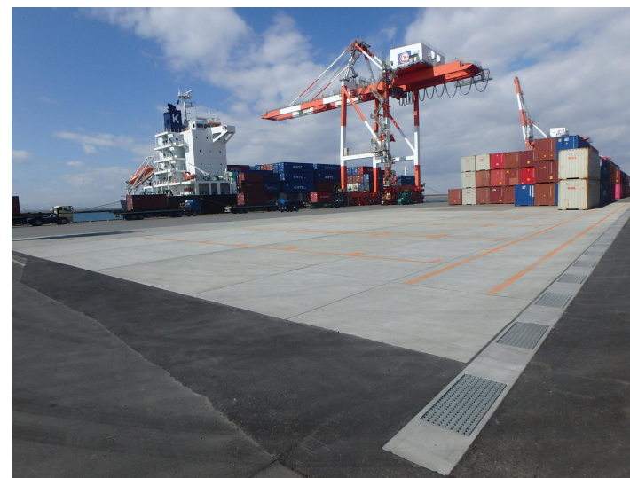
コンテナヤードの復旧完了状況
