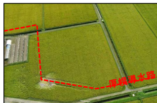
【勇払東部地区】厚幌導水路等 管水路の離脱・漏水
