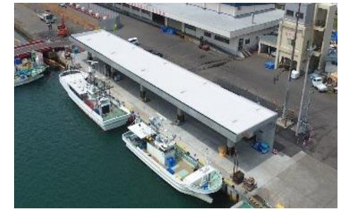
水産物の輸出促進のための 屋根付き岸壁等の整備 (苫小牧港:R2.3完成)
