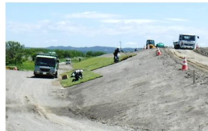
整形完了後、植生を実施。
