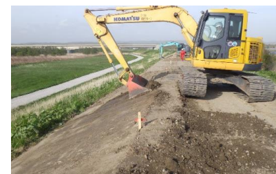
切り返し盛り土が完了した箇所から順次、整形を実施。
