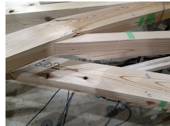
1/15rad 筋かいの亀裂
