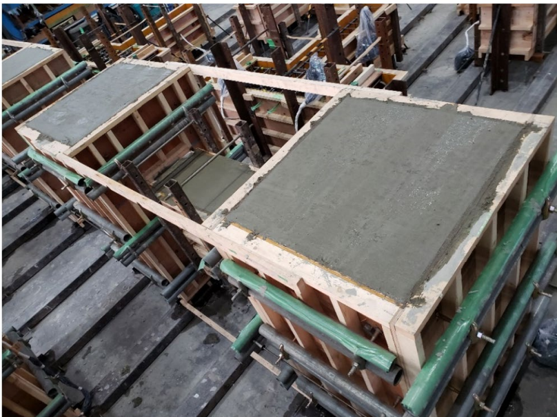
コンクリート打設
