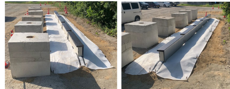
透水シートの設置(地中部の乾燥防止用) 図-5 透水シートの設置状況
