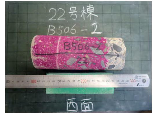
バルコニー 中性化状況
