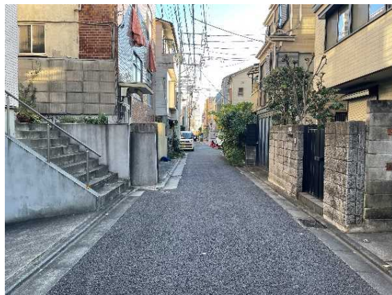
幅員が4 m未満の狭あい道路の拡幅
