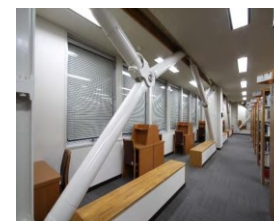
補強材(筋かい)の設置
