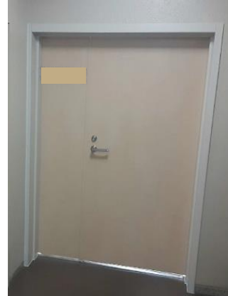
改修後 (カバー工法・不燃扉)
