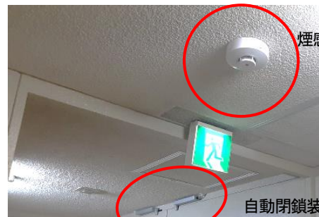
改修後（煙感知器連動方式）
