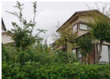
植栽が繁茂した空き家 出典)国土交通省HP
