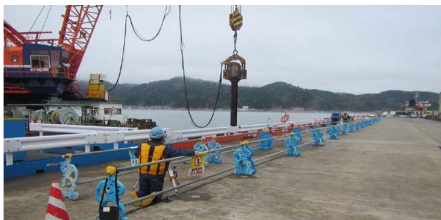
海上作業時の陸上からの視点（上：3次元モデル計画、下：現地稼働状況）
