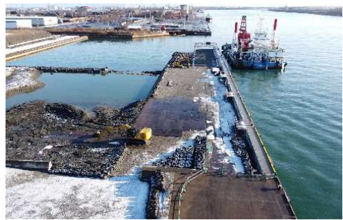
苫小牧港西港区真古舞地区の岸壁整備
