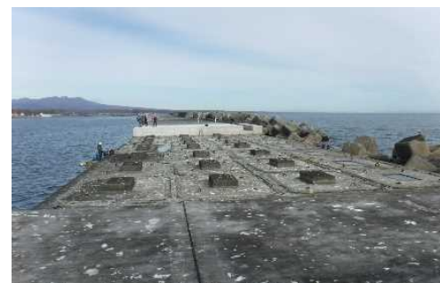
白老港の防波堤整備
