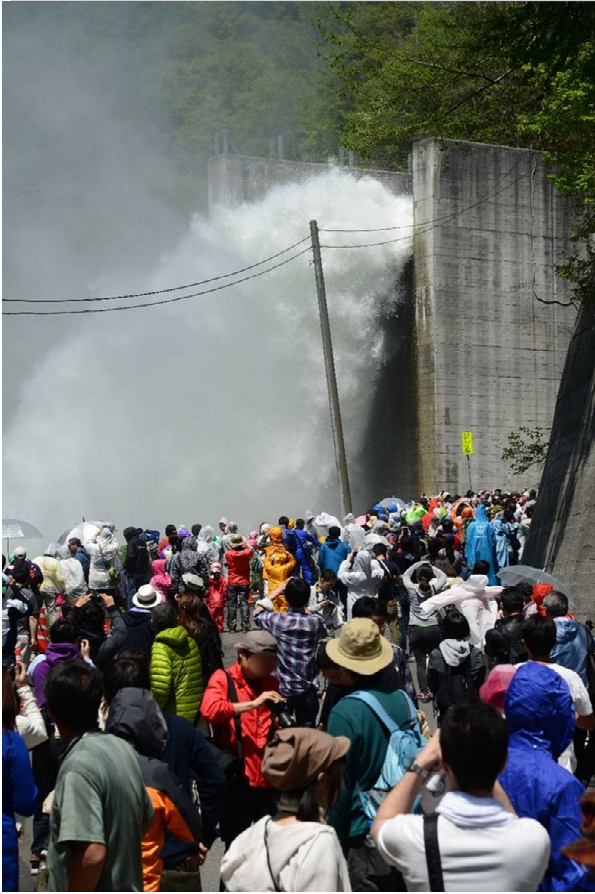
矢木沢ダム・奈良俣ダム・藤原ダム点検
