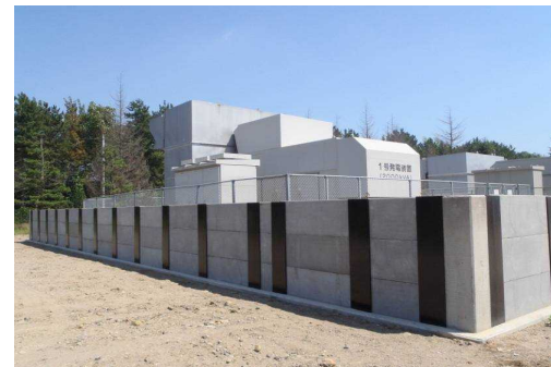
防水壁の設置
