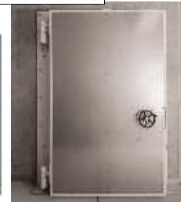
防水扉の設置
