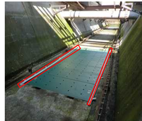
飛散防止金具の設置
