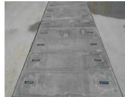
コンクリート製の覆蓋への変更
