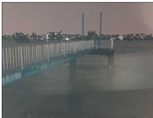
東日本台風の際の河川の状況
