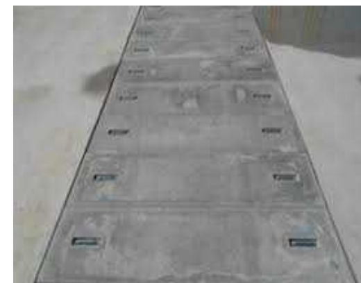
コンクリート製の覆蓋への変更
