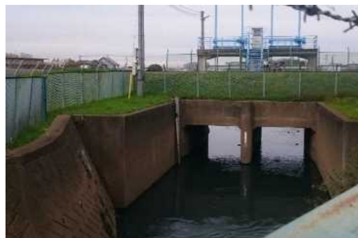
河川水位が上昇したため樋門が閉鎖
