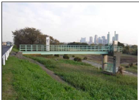
堤外側でゲート进行操作する樋門
