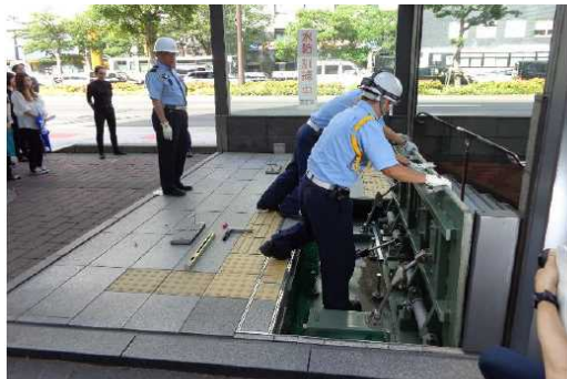
手動起上式止水板設置
