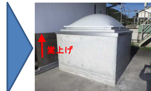
トプライトの止水対策 (左:実施前 右:実施後)
