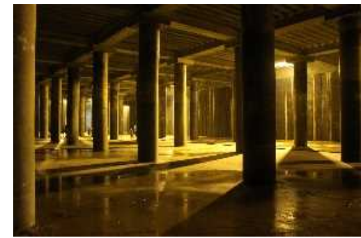
貯留施設の整備
