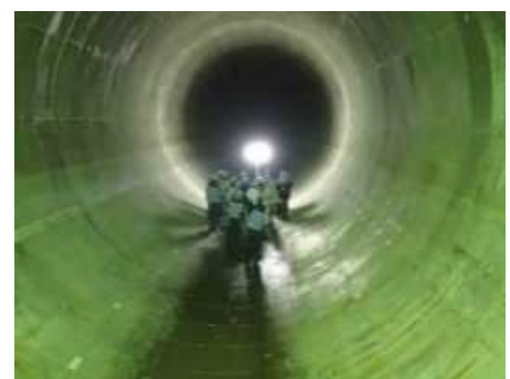
雨水貯留管の整備
