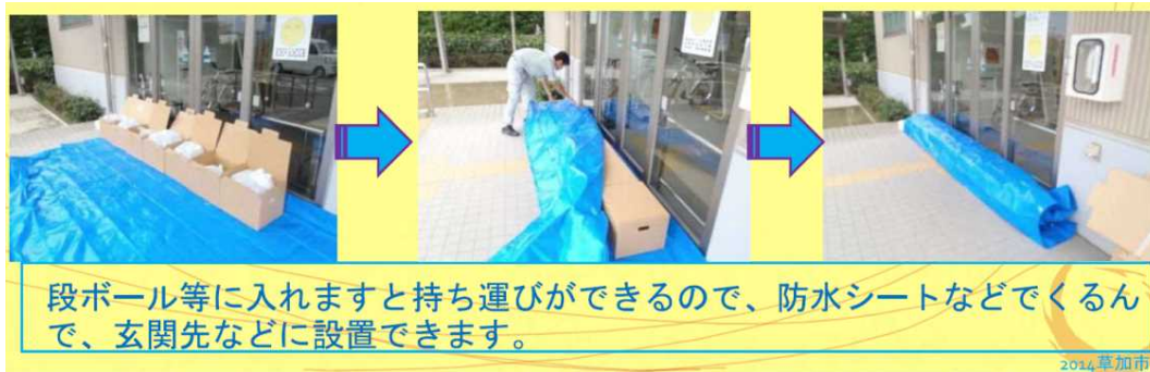
簡易「水のう」の設置例
