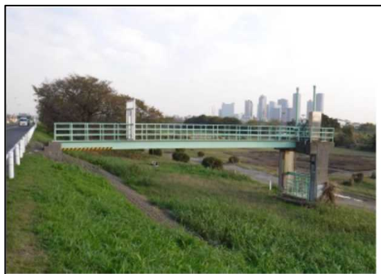
堤外側でゲート进行操作する樋門
